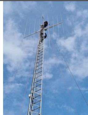
Montage nieuwe antenne
